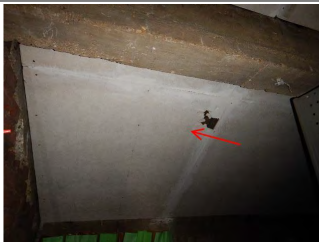
013 : Panneaux fibreux en plafond L202 - PRE:PP004
